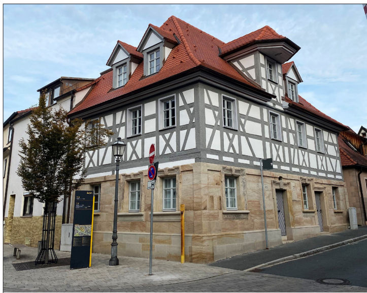
Denkmalprämiertes und privat saniertes Fachwerkhaus in der Hintere Gasse. Foto: Stadt
