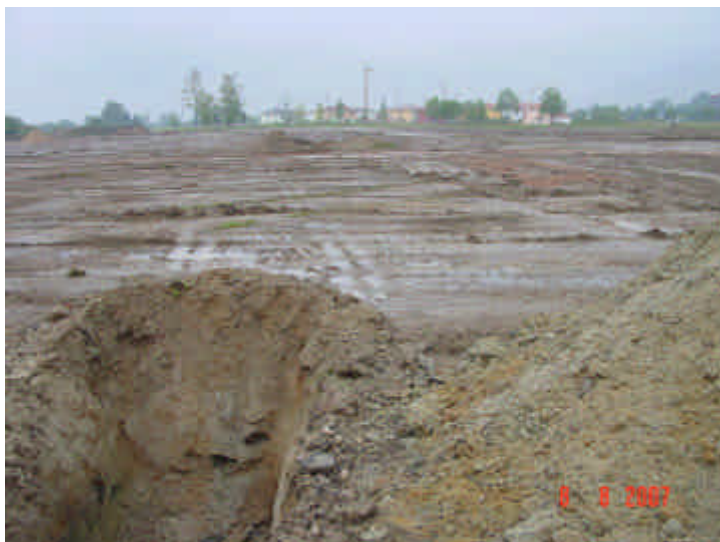
Bild 9: Sanierung F58, Westteil Ansicht von Osten Sanierungsfläche nach dem Abtrag des Oberbodens
