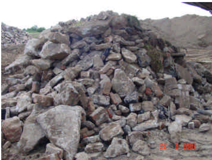
Bild 21: Sanierung F58 Sortierbereich, Haufwerke mit ausgesiebter Grobfraktion
