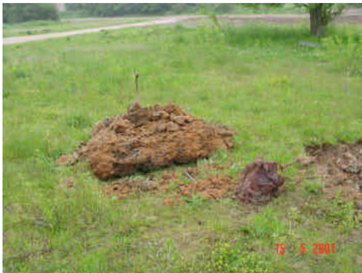
Bild 8: Schurfgrube S23 ausgebauter Antennenanker
