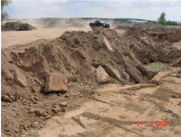
Bild 25: Sanierung F58 Ansicht von Westen Auffüllungen mit Beton- und Bauschutteilen > 60 cm
