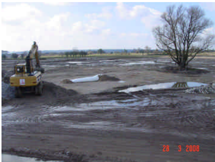
Bild 42: Sanierung F58 Ansicht von Nord/Ost Fläche zum Zeitpunkt der Abschlussbeprobung
