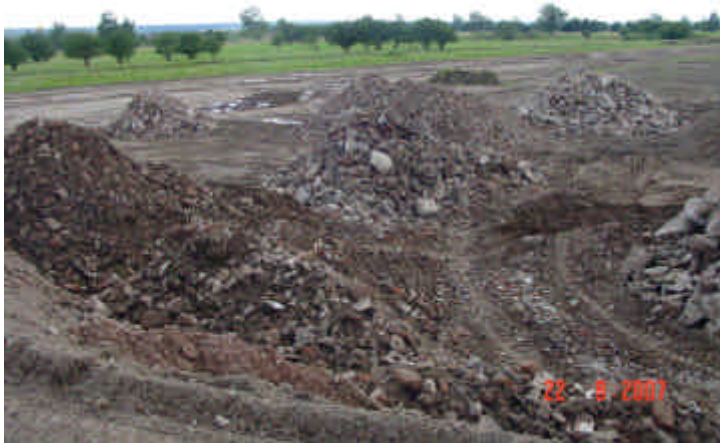
Bild 19: Sanierung F58 Ansicht von Nord/Ost Sortierbereich mit Haufwerken der ausgesiebten Grob- und Mittelfractionen
