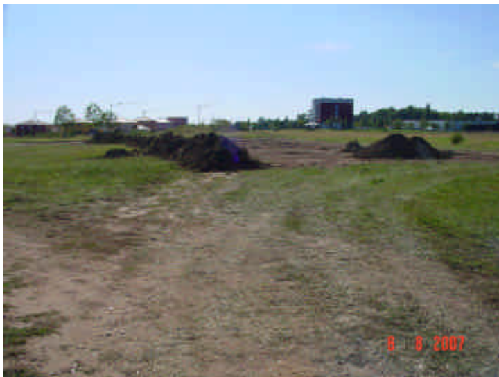
Bild 8: Sanierung F58, Westteil Ansicht von Osten Abtrag des Oberbodens zu Beginn der Sanierungsmaßnahme
