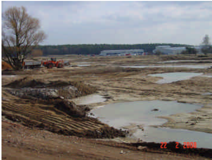
Bild 40: Sanierung F58 Ansicht von Nord/West Fläche nach Fertigstellung der Sanierungsarbeiten
