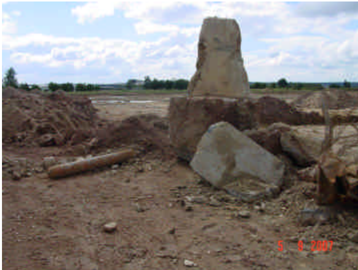
Bild 26: Sanierung F58 Aus der Auffüllung aussortierter Schrott und ein Antennenfundament
