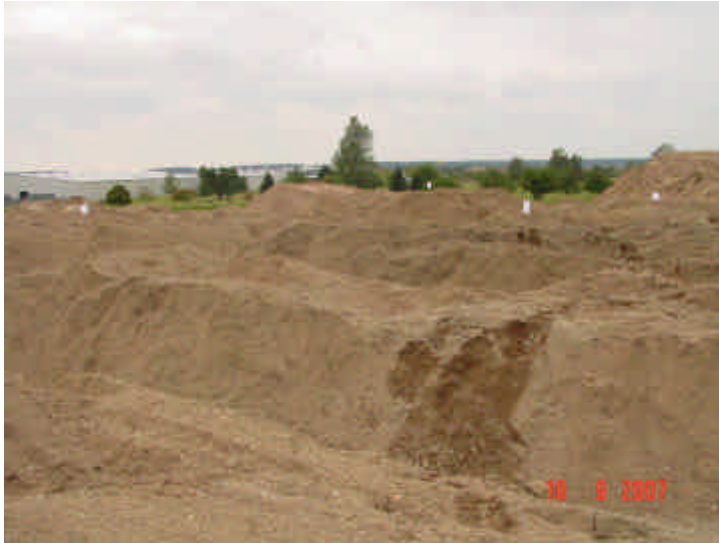
Bild 28: Sanierung F58 Siebbereich Ansicht von Norden Markierte und beprobte Haufwerke mit Feinabsiebungen
