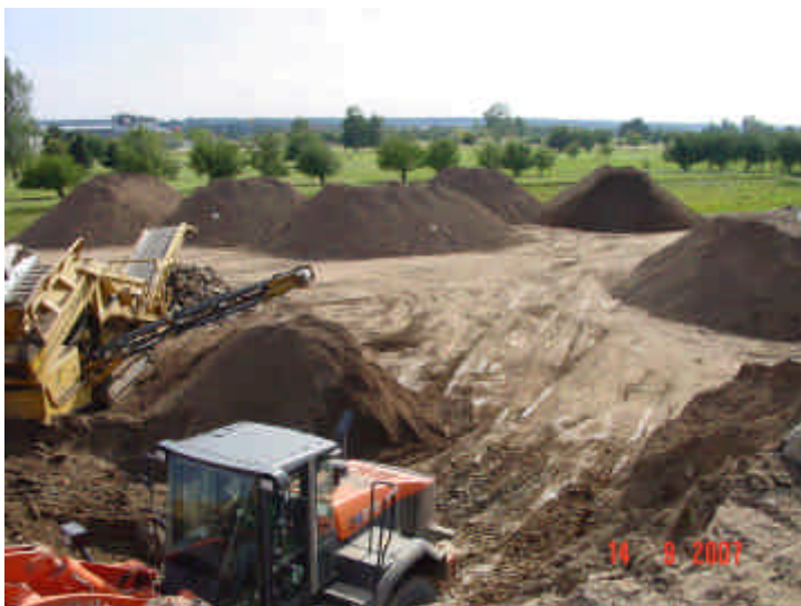
Bild 30: Sanierung F58, Bereich Süd Ansicht von Nord/Ost Siebbereich mit Haufwerken der Feinabsiebung
