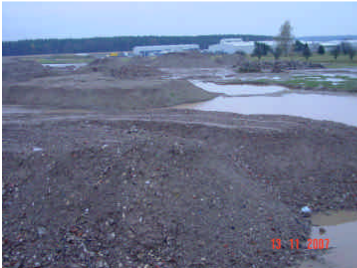
Bild 35: Sanierung F58 Ansicht von Nord/West Haufwerke mit verschiedenen Siebfractionen
