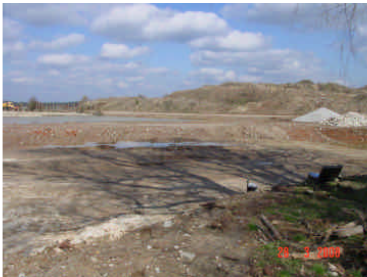
Bild 41: Sanierung F58 Ansicht von Süd/West Fläche Nord zum Zeitpunkt der Abschlussbeprobung
