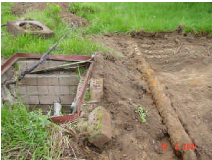
Bild 3: Schurfgrube S9.1 Ansicht von Süden Alte Leitung unterhalb der Grasnarbe mit Schachtbau- werk
