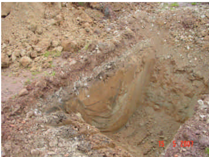
Bild 12: Schurfgrube S34 Schotteraufbau von alter Pan- zerstraße
