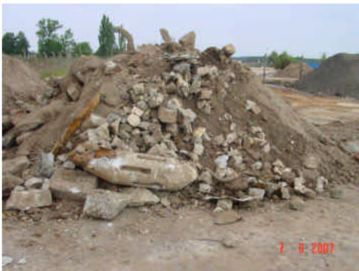
Bild 27: Sanierung F58 Haufwerk mit ausgekoffertem Boden-/Schotter- und Schwarzdeckengemisch; im Vordergrund aussortierte Übungsbombe
