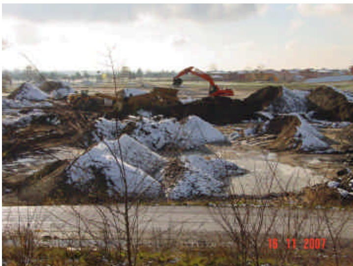
Bild 36: Sanierung F58 Ansicht von Nord/Ost Haufwerke mit verschiedenen Siebfractionen
