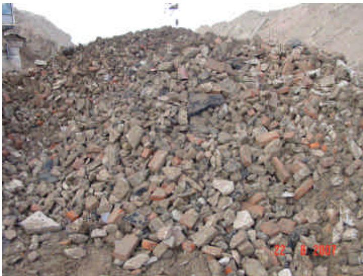
Bild 20: Sanierung F58 Sortierbereich, Haufwerke mit ausgesiebter Mittelfraction
