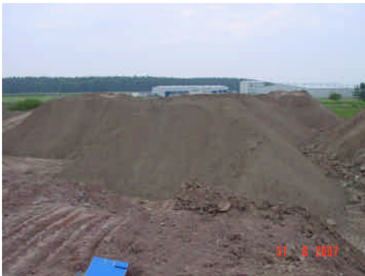
Bild 23: Sanierung F58 Sortierbereich Ansicht von Norden Feinabsiebungen von Haufwerk 5
