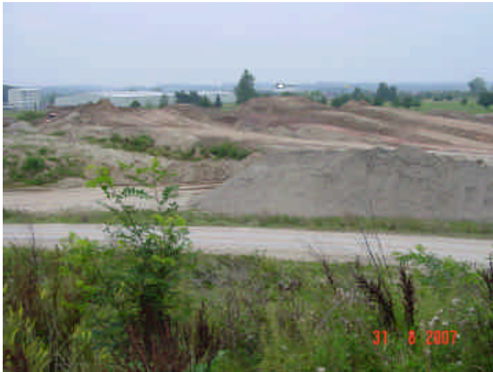
Bild 22: Sanierung F58, Ostteil Sortierbereich Ansicht von Norden Haufwerke zur Siebung mit ausgekofferten Auffüllungen
