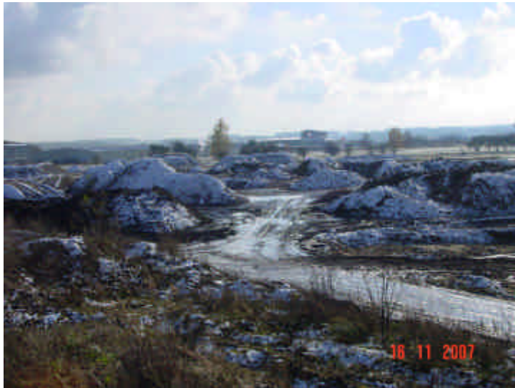
Bild 37: Sanierung F58 Ansicht von Norden Haufwerke mit verschiedenen Siebfraktionen
