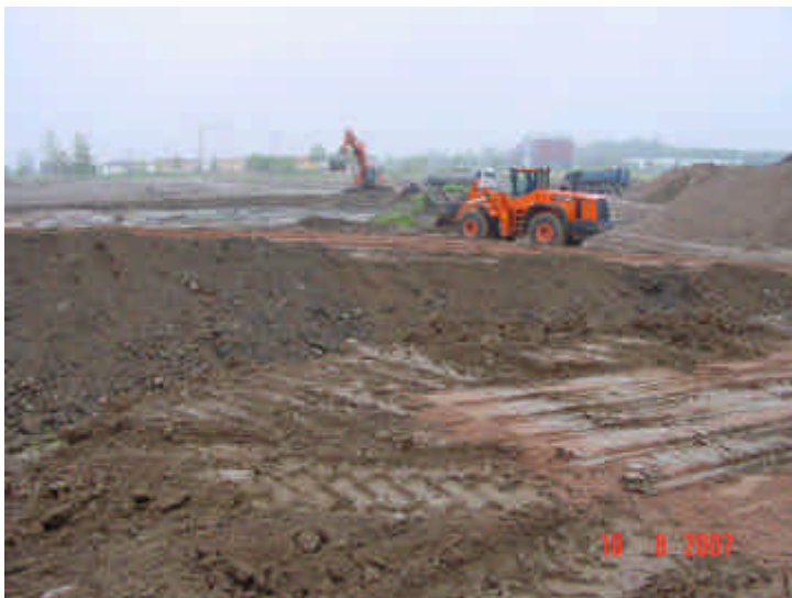
Bild 11: Sanierung F58 Ansicht von Osten Sanierungsfläche zu Beginn der Aushubarbeiten
