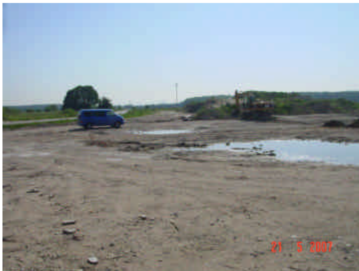
Bild 14: östliches adidas Gelände Ansicht von Westen abgelagerte Haufwerke
