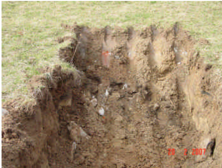
Bild 4: Voruntersuchung F58 Erkundungsschurf zerstörter Schwarzdeckenaufbau mit Überdeckung aus Boden- Bauschuttgemisch
