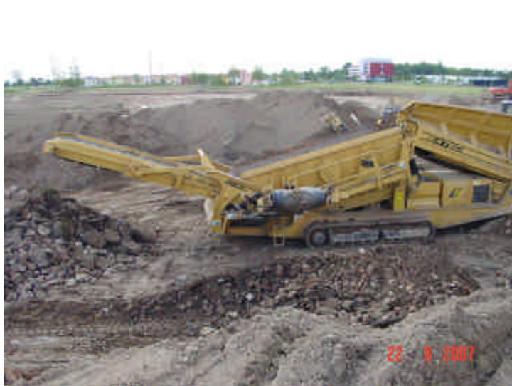
Bild 18: Sanierung F58 Ansicht von Osten Sortierbereich bei der Siebung der Auffüllungen
