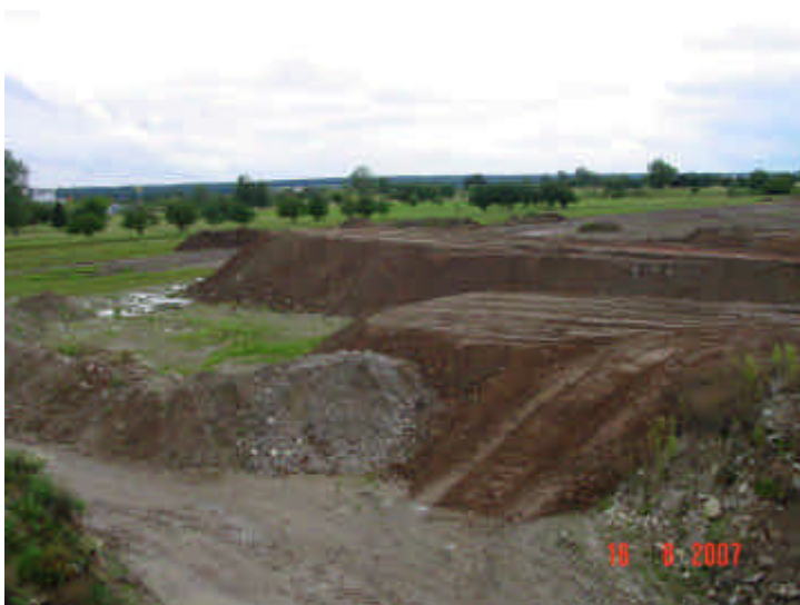
Bild 15: Sanierung F58 Ansicht von Nord/Ost Haufwerke im Siebbereich mit ausgekoffertem Bodenmaterial
