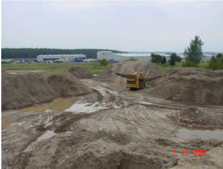
Bild 34: Sanierung F58 Siebbereich Ansicht von Nord/West Haufwerke mit verschiedenen Siebfractionen
