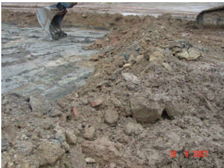
Bild 12: Sanierung F58 Sanierungsfläche beim Abtrag der schadstoffhaltigen Auffüllungen
