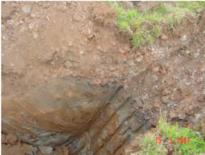
Bild 11: Schurfgrube S32 Baustraßenbau, Proben- bez. C2-11/MP1 Dunkle Schicht mit modrigem Geruch, Probenbez. C2- 11/MP2
