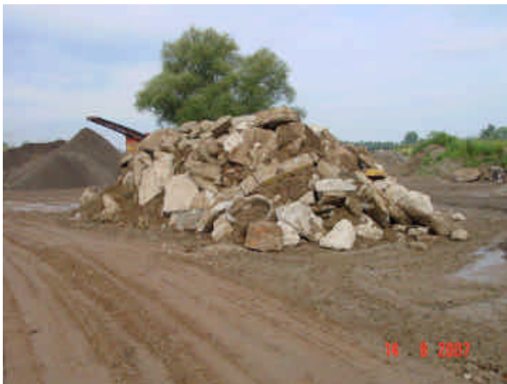
Bild 14: Sanierung F58 Haufwerk mit aussortierten Bauschuttteilen > 60 cm
