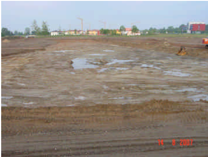
Bild 13: Sanierung F58, Süd-/Westteil Ansicht von Osten Sanierungsfläche nach dem Abtrag der schadstoffhaltigen Auffüllungen
