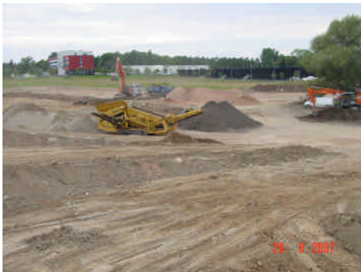
Bild 17: Sanierung F58 Ansicht von Osten Sortierbereich
