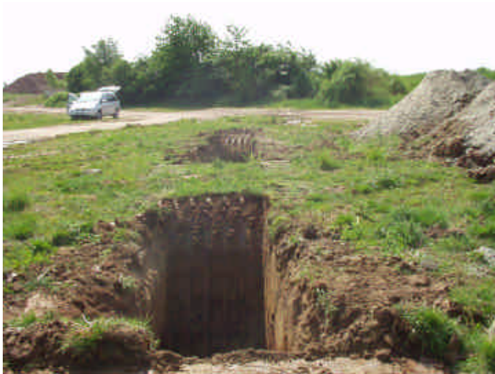
Bild 8: Lage der Schurfe 1 (hinten) und 2 (vorne) (Blick von Nordwesten) (Untersuchungsphase: DU)
