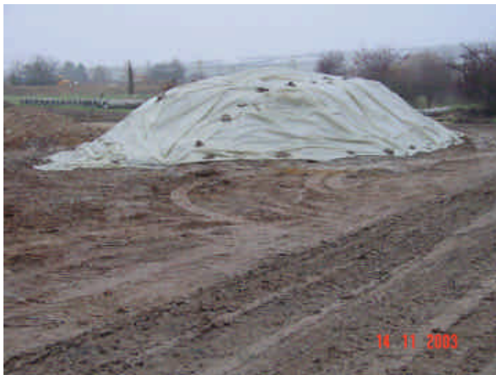
Bild 2: Abgedecktes Haufwerk aus kontaminierten Aushubmaterialien (Untersuchungsphase: Erstuntersuchungen Kanalbau)
