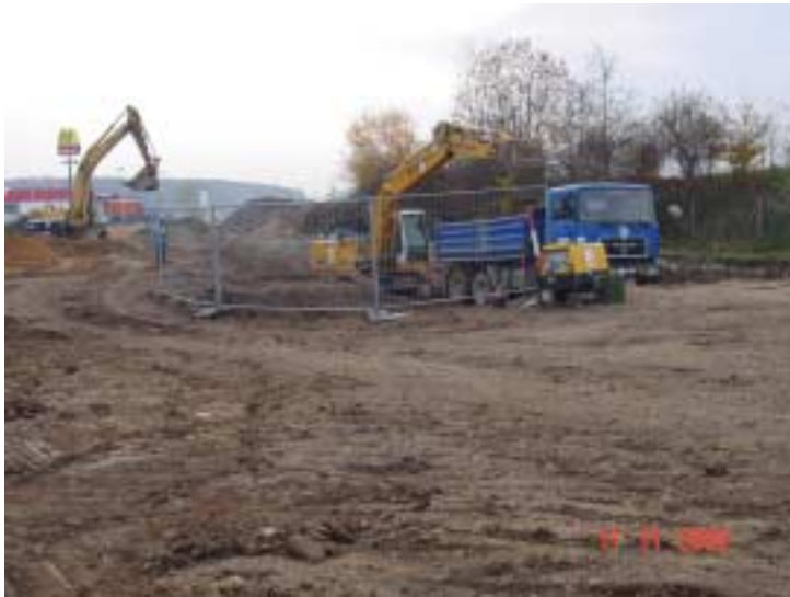
Bild 1: Aushub zur Errichtung der Schachtbauwerke
