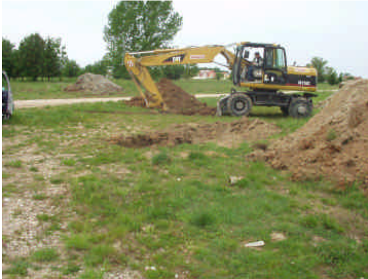
Bild 16: Lage Schurfe 7 (vorne) und 12 (hinten) (Blick von Südosten) (Untersuchungsphase: DU)
