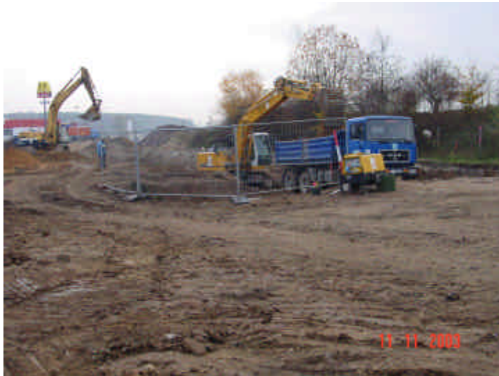
Bild 1: Aushub zur Errichtung der Schachtbauwerke (Untersuchungsphase: Erstuntersuchungen Kanalbau)
