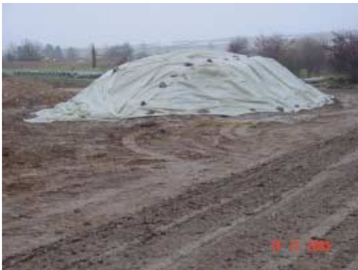
Bild 2: Abgedecktes Haufwerk aus kontaminierten Aushubmaterialien
