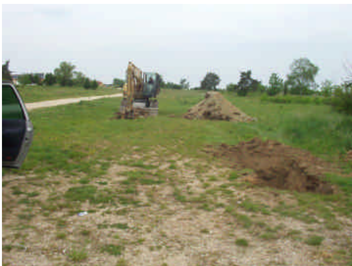
Bild 12: Lage Schurfe 7 (vorne rechts) und 8 (Blick von Süden) (Untersuchungsphase: DU)
