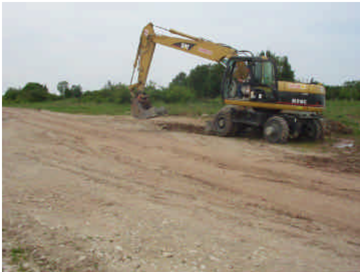
Bild 14: Lage Schurf 10 (Blick von Südosten) (Untersuchungsphase: DU)
