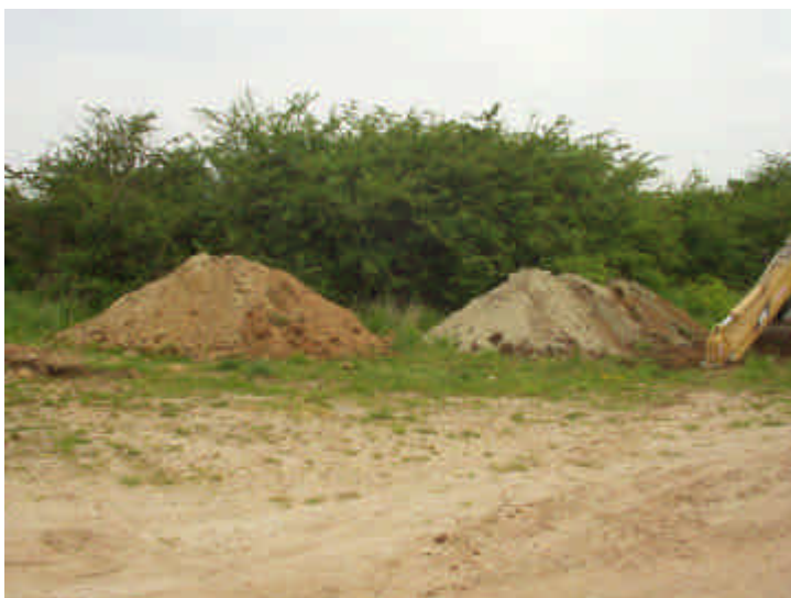
Bild 15: Lage Schurf 11 (Blick von Südwesten) (Untersuchungsphase: DU)
