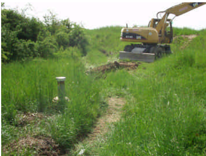
Bild 9: Lage Schurf 4 mit bestehendem Pegel (Blick von Norden) (Untersuchungsphase: DU)
