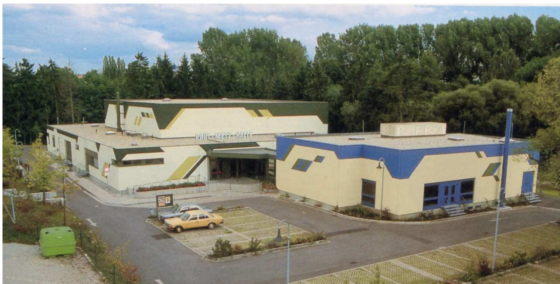
Abb. 17: Paul-Metz-Halle von außen
