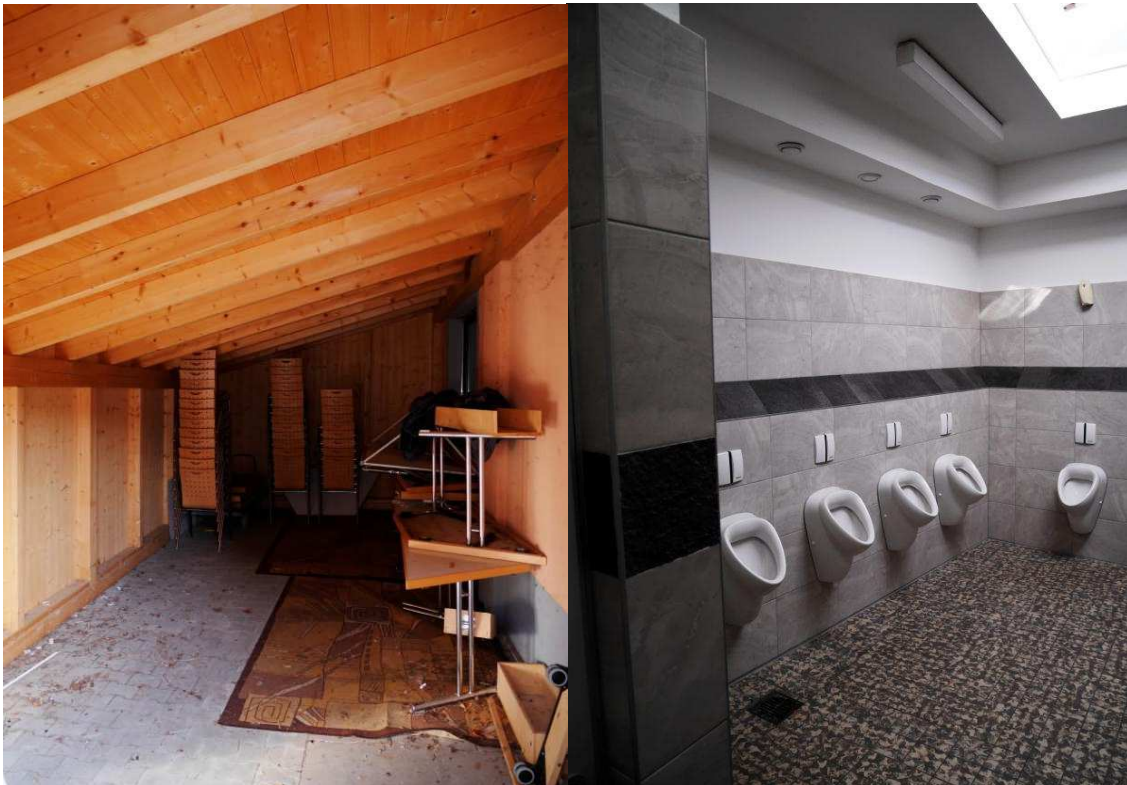
Abb. 58 - 59 von links: außenliegendes „Stuhllager“; Toiletten
