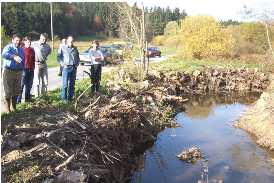
Bild 8: Böschungssicherung durch Wurzelstöcke
