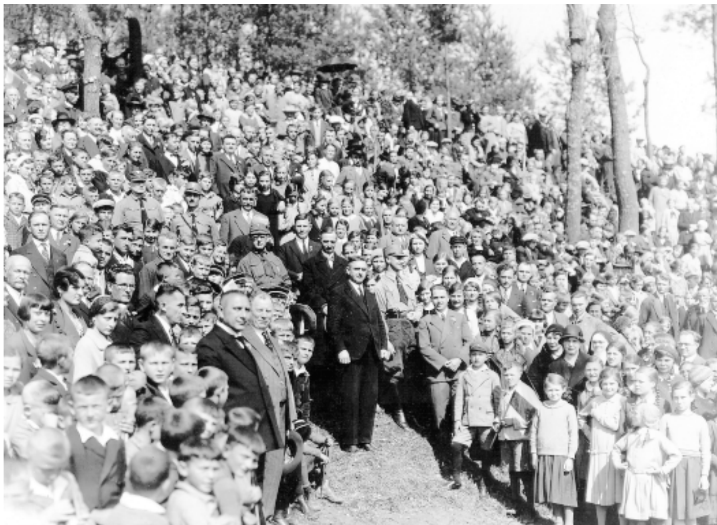
Valentin Fröhlich beim 1. Spatenstich am Eichenbrünnlein zum Bau der neuen Wasserleitung am 1. Mai 1933.
