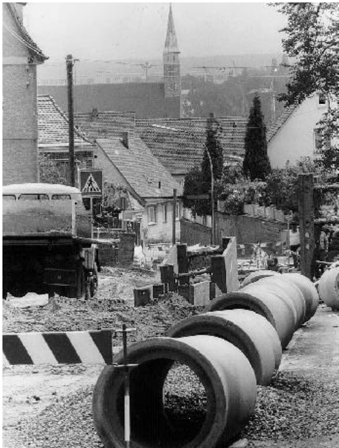
Bamberger Straße 1978 - Kanalbauarbeiten belasten die städtischen Kassen
