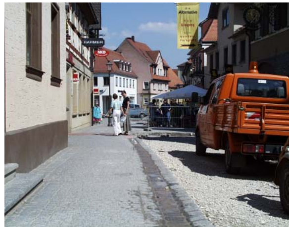
Umbau der Hauptstraße
