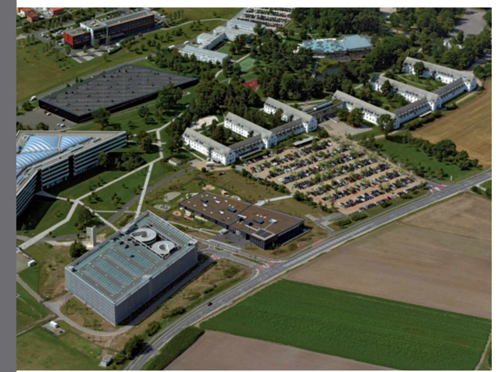
Die „Kammgebäude“ des Fliegerhorsts wurden in die adidas-Firmenzentrale integriert, 2014
