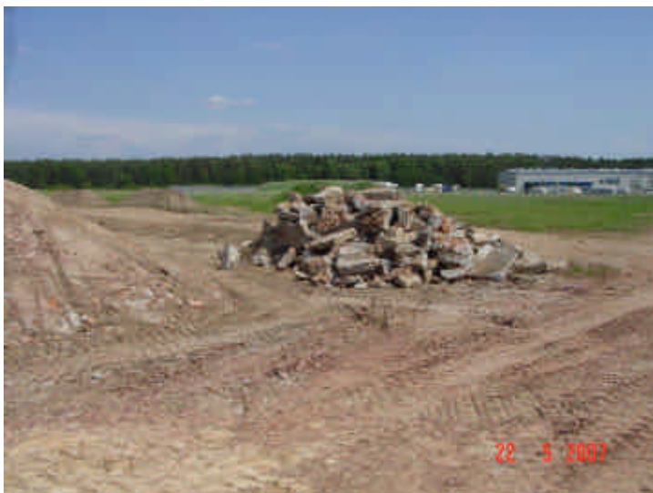
Bild 21: Sanierung Landebahn Ostteil F43, 2007 Teile der ausgebauten Betonrinne mit Teeranstrich
