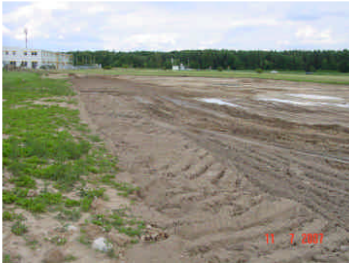
Bild 25: Sanierung Landebahn Ostteil F43, 2007 Landebahn Ost nach Fertigstellung der Sanierungsarbeiten - Ansicht von Westen
