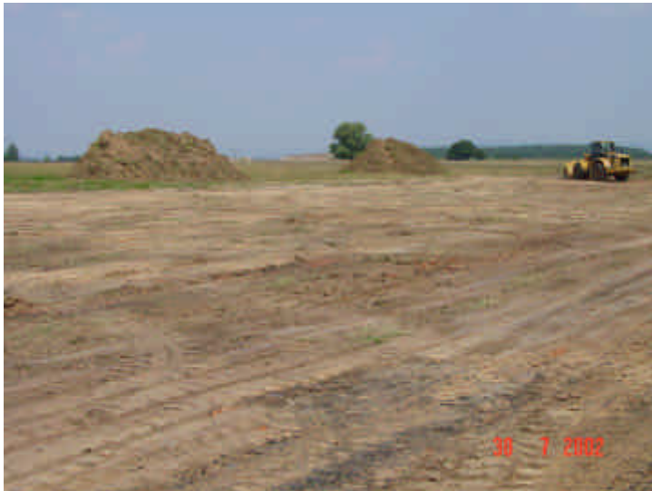
Bild 2: Altlastensanierung II, 2002/03 Sanierungsfläche nach dem Abraum des Oberbodens – Grasnarbe z.T. vermischt mit Ziegel/Teer
