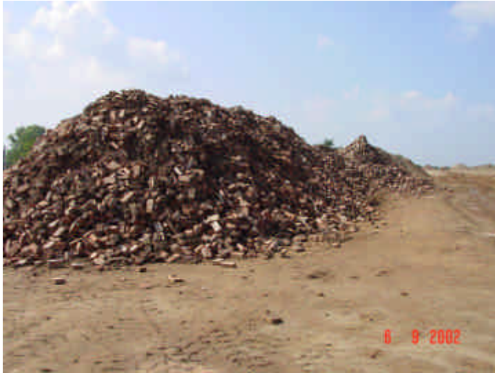
Bild 7: Altlastensanierung II, 2002/03 Separierter Landebahnbelag Ziegel mit Teerbelag
