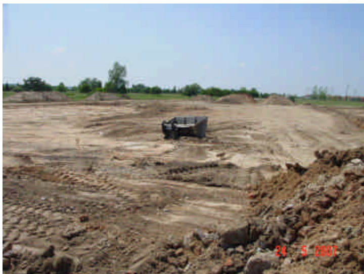
Bild 24: Sanierung Landebahn Ostteil F43, 2007 Sanierungsfläche F43 - Ansicht von Osten
