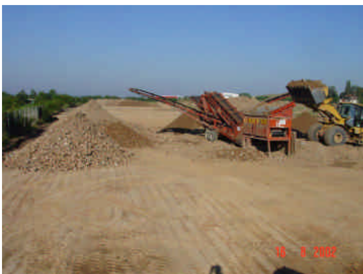
Bild 6: Altlastensanierung II, 2002/03 Klassierung des abgetragenen Landebahnbelags mittel Siebung mit Harfensieb
