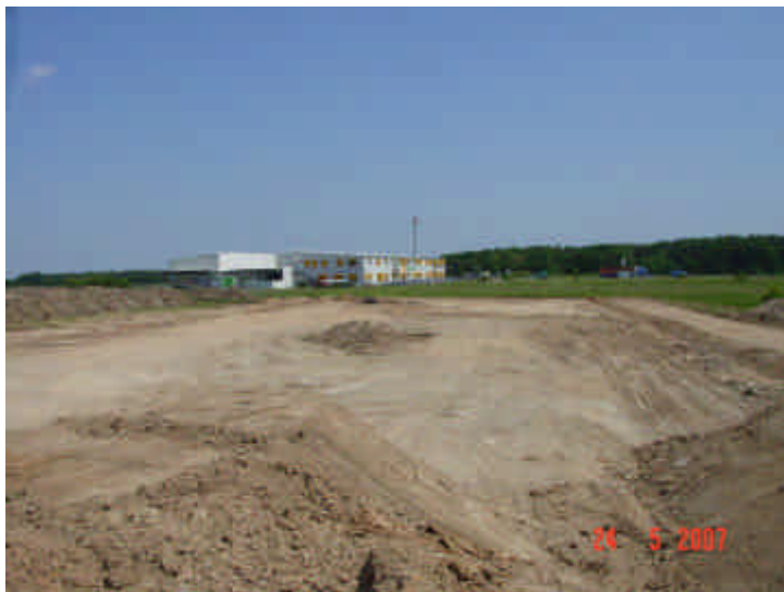
Bild 23: Sanierung Landebahn Ostteil F43, 2007 Sanierungsfläche F43 - Ansicht von Westen
