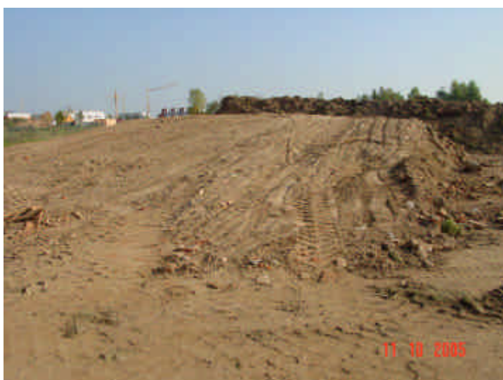
Bild 15: Sanierung Golfplatzgelände /Teilbereich Landebahn, 2005 Haufwerk mit abgeräumten Landebahnaufbau – Ziegel/Teerbelag mit Bodenmaterial vermischt
