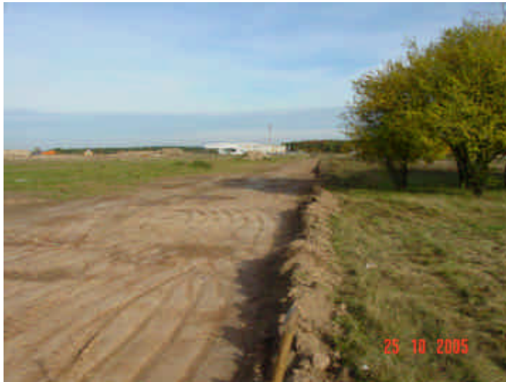
Bild 16: Sanierung Golfplatzgelände /Teilbereich Landebahn, 2005 südliche Landebahnfläche nach dem Abtrag des Aufbaus – Ansicht von Westen
