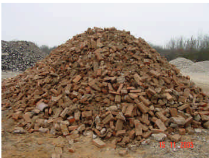
Bild 18: Sanierung Golfplatzgelände /Teilbereich Landebahn, 2005 Siebung Landebahnaufbau - Grobabsiebung
