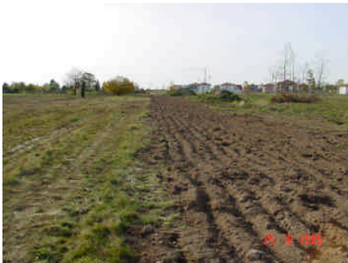
Bild 17: Sanierung Golfplatzgelände /Teilbereich Landebahn, 2005 südliche Landebahnfläche, Ostteil nach dem Wiedereinbau von Bodenmaterial – Ansicht von Osten
