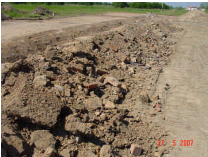
Bild 20: Sanierung Landebahn Ostteil F43, 2007 Abraum vom zerstörten Landebahnaufbau (Ziegel/Teer) mit Bodenmaterial vermischt
