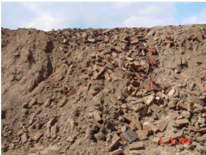
Bild 5: Altlastensanierung II, 2002/03 Haufwerk mit Abraummaterial vom Landebahnbelag Ziegel mit Teerbelag - Detailansicht
