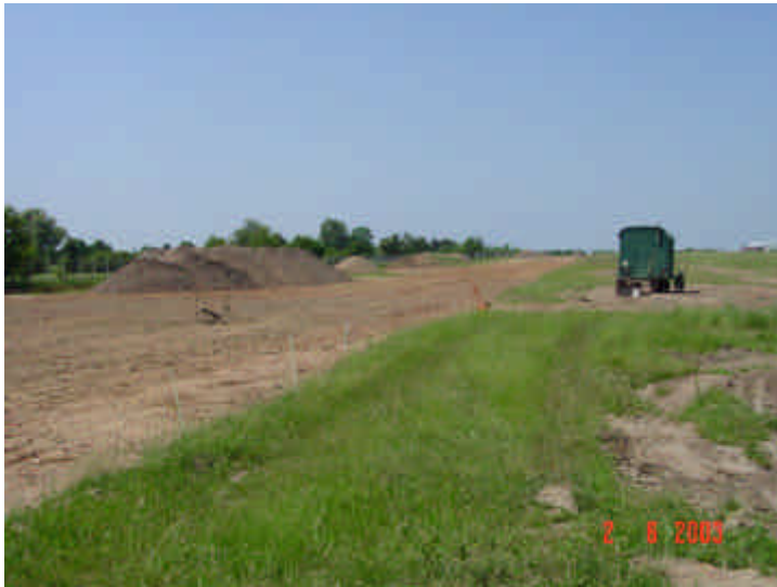
Bild 10: Altlastensanierung II, 2002/03 sanierte Landebahnfläche mit Haufwerken zum Wiedereinbau – Ansicht von Osten
