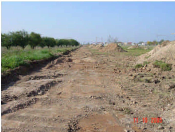
Bild 14: Sanierung Golfplatzgelände /Teilbereich Landebahn, 2005 südliche Landebahnfläche nach dem Abtrag des Aufbaus – Ansicht von Osten
