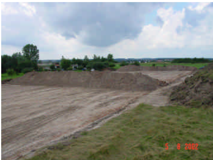
Bild 3: Altlastensanierung II, 2002/03 Abraum vom Landebahnbelag Ziegel mit Teerbelag, vermischt mit Erdreich Lagerung auf Haufwerken – Ansicht von Osten
