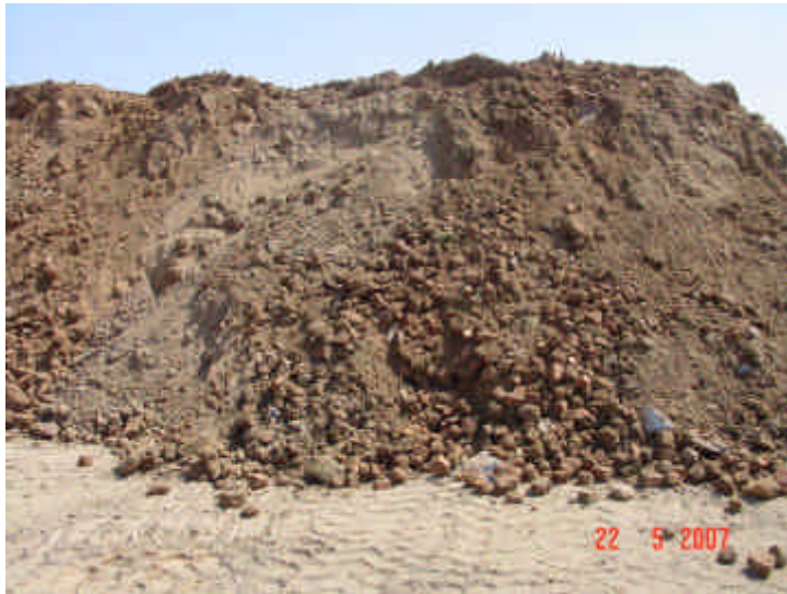
Bild 22: Sanierung Landebahn Ostteil F43, 2007 Haufwerk mit Abraummaterial der Landebahn Ziegel-/Teer- /Bodengemisch
