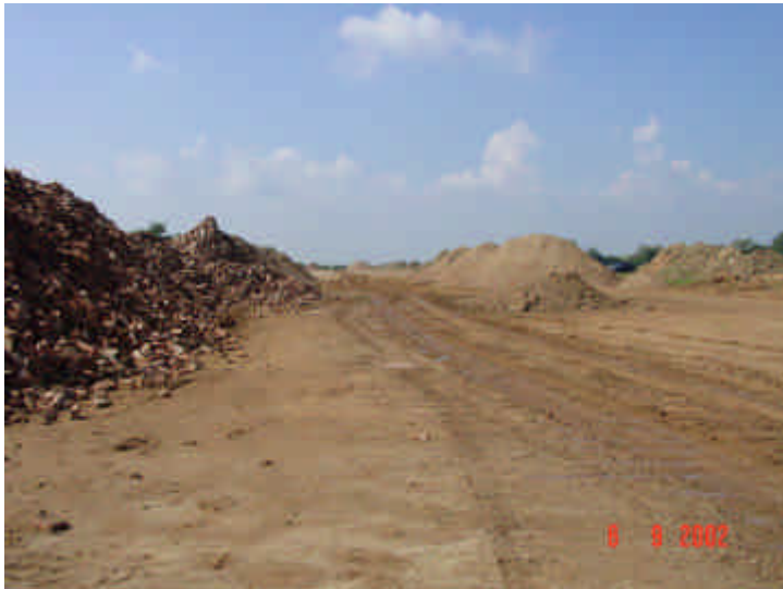
Bild 8: Altlastensanierung II, 2002/03 Haufwerke mit den verschiedenen Siebfraktionen
