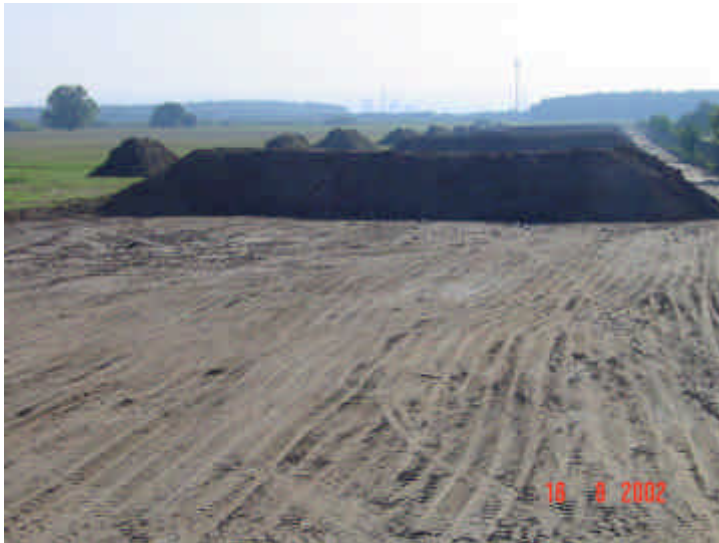
Bild 4: Altlastensanierung II, 2002/03 Abraum vom Landebahnbelag Ziegel mit Teerbelag, vermischt mit Erdreich Lagerung auf Haufwerken – Ansicht von Westen
