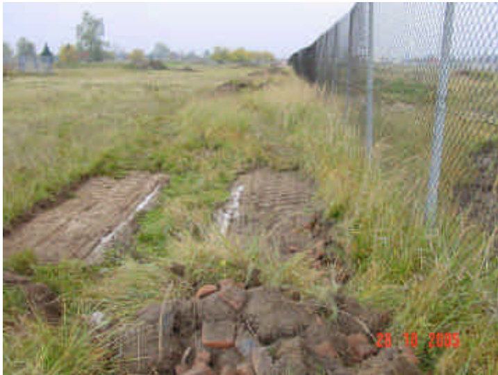
Bild 19: Sanierung Landebahn Ostteil F43, 2007 Voruntersuchung 2005 - südliche Betonrinne mit Landebahnaufbau (Ziegel/Teer) im Vordergrund
