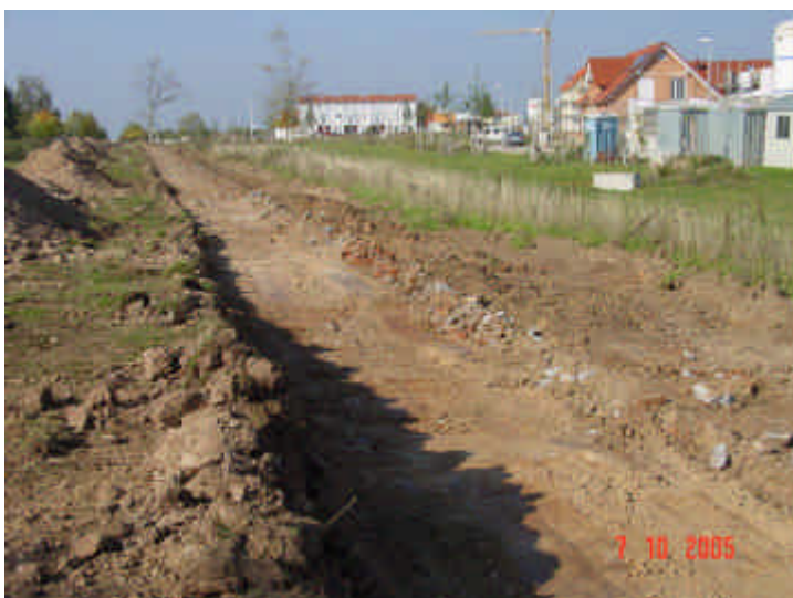
Bild 12: Sanierung Golfplatzgelände /Teilbereich Landebahn, 2005 südliche Landebahnfläche nach dem Abtrag des Oberbodens – Ansicht von Osten
