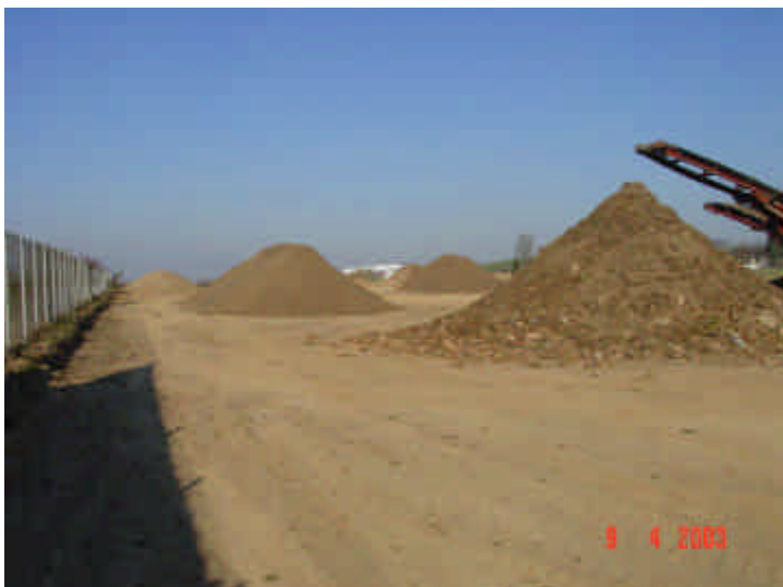
Bild 9: Altlastensanierung II, 2002/03 Klassierung des Oberbodens Trennung Humus und Ziegel Teerbestandteile – im Hintergrund Haufwerke mit Feinsiebungen
