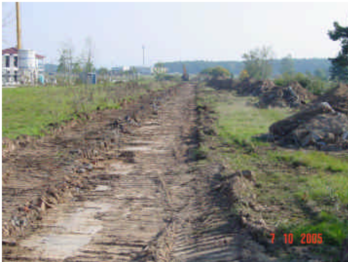
Bild 11: Sanierung Golfplatzgelände /Teilbereich Landebahn, 2005 südliche Landebahnfläche nach dem Abtrag des Oberbodens – Ansicht von Westen
