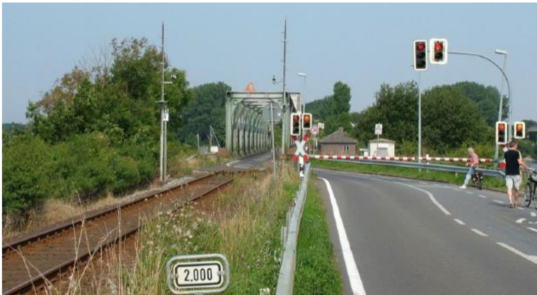
Abbildung 17: Schrankengeregelte Mischnutzung der Eisenbahnbrücke bei Lindaunis
