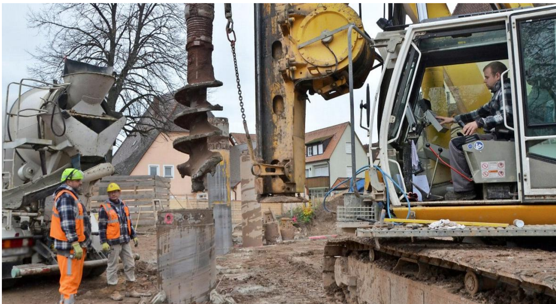
Das 90 Tonnen schwere und 22 Meter hohe Bohrgerät muss Millimeterarbeit leisten. Die Bohrungen auf der Baustelle haben begonnen.
