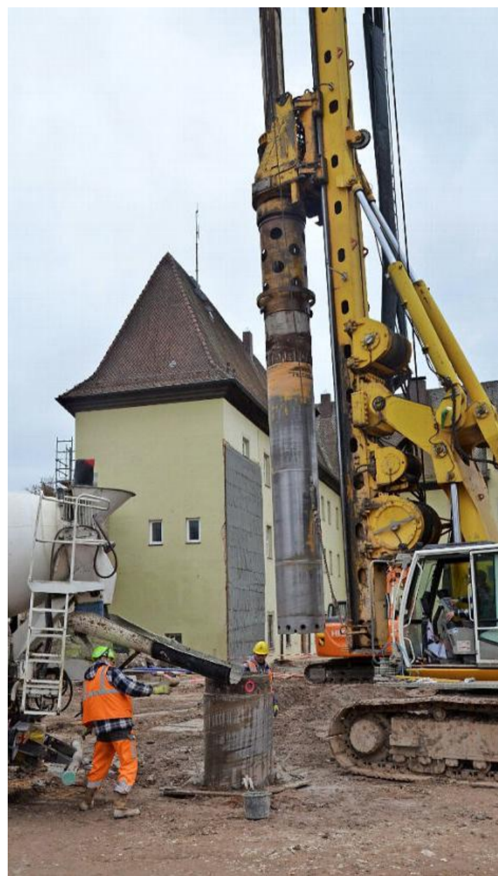
Erst werden die Löcher gebohrt, dann mit Beton verfüllt. Die nächsten zehn Wochen geht das so, insgesamt 267 Mal.
