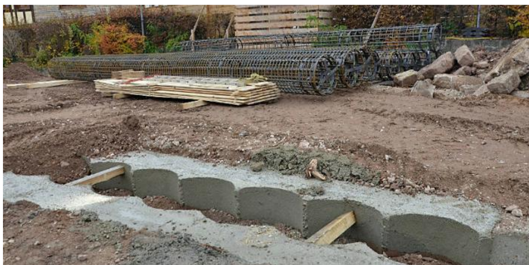
Vorne die betonierten Bohr-Schablonen, im Hintergrund der Bewehrungsstahl
