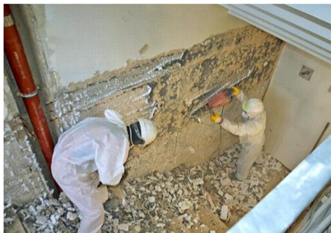
Arbeiter entfernen die Styroporverkleidung neben der Treppe in den Keller.
