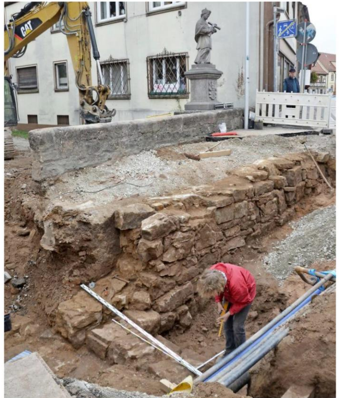
Die eine Mauer ist auf alt gemacht, die andere original: Im Hintergrund die „neue“ Mauer mit dem Brunnenheiligen, vorne die Brückenwand aus dem 16. Jahrhundert. Fotos: Bernhard Panzer
