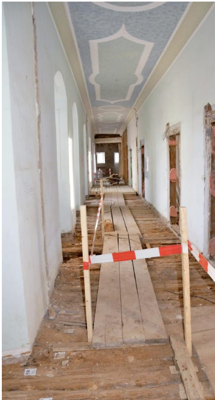
Alle Balken sind freigelegt worden.
