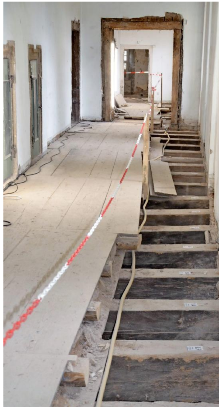
Im Innern ist das Schloss eine Großbaustelle.
