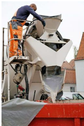
Der Beton fließt.
