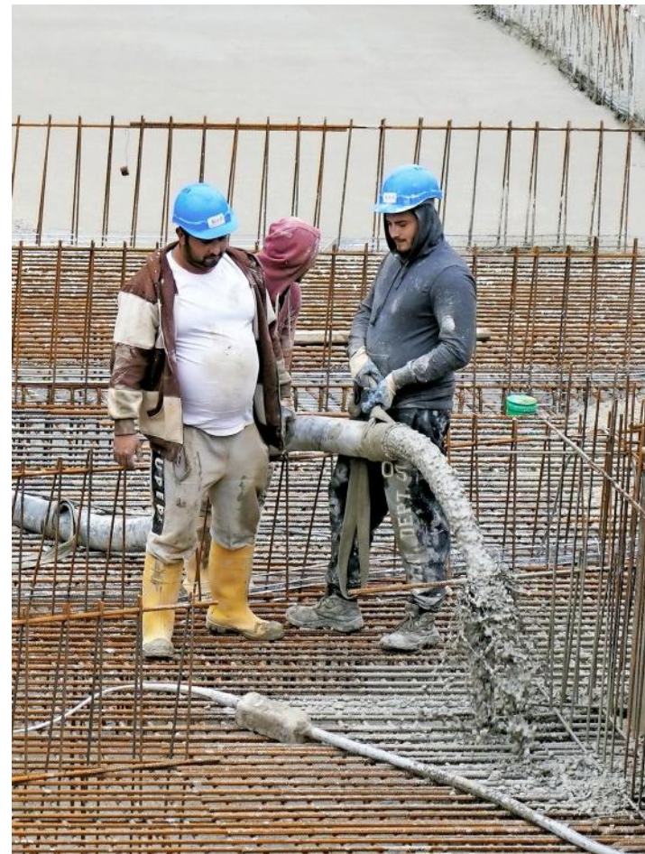
Aus dem Schlauch wird der Beton in die Armierung gegossen.
