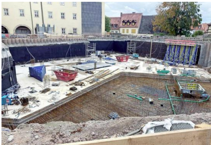
Ein Blick in die Baustelle
