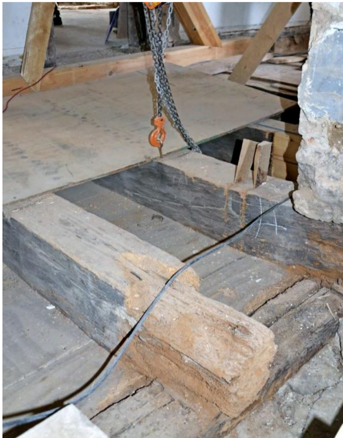
Manch Balkenköpfe sind sehr in Mitleidenschaft gezogen. Sie werden sorgfältig durch neues Holz ersetzt.
