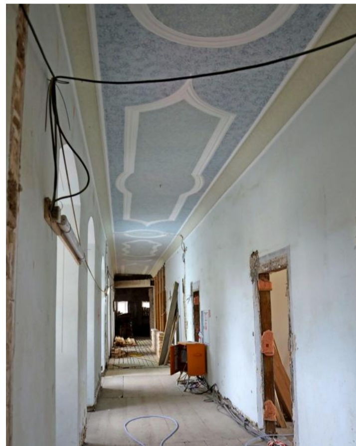
Ein Blick auf ein Detail der Großbaustelle Schlossgebäude
