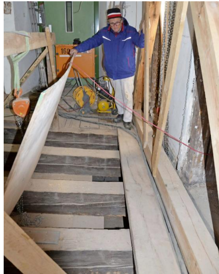
Restaurator Adalbert Wiech auf dem Deckengebälk, das den Kamin trug. Es haben sich buchstäblich die Balken gebogen.
