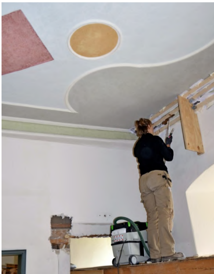
Mitarbeiterin Clara Mangold beim Sichern der Stuckdecke
