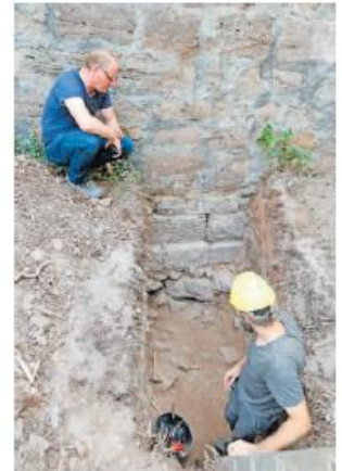
Die mittelalterliche Burgmauer ist auf ein älteres Mauerwerk aufgesetzt.
