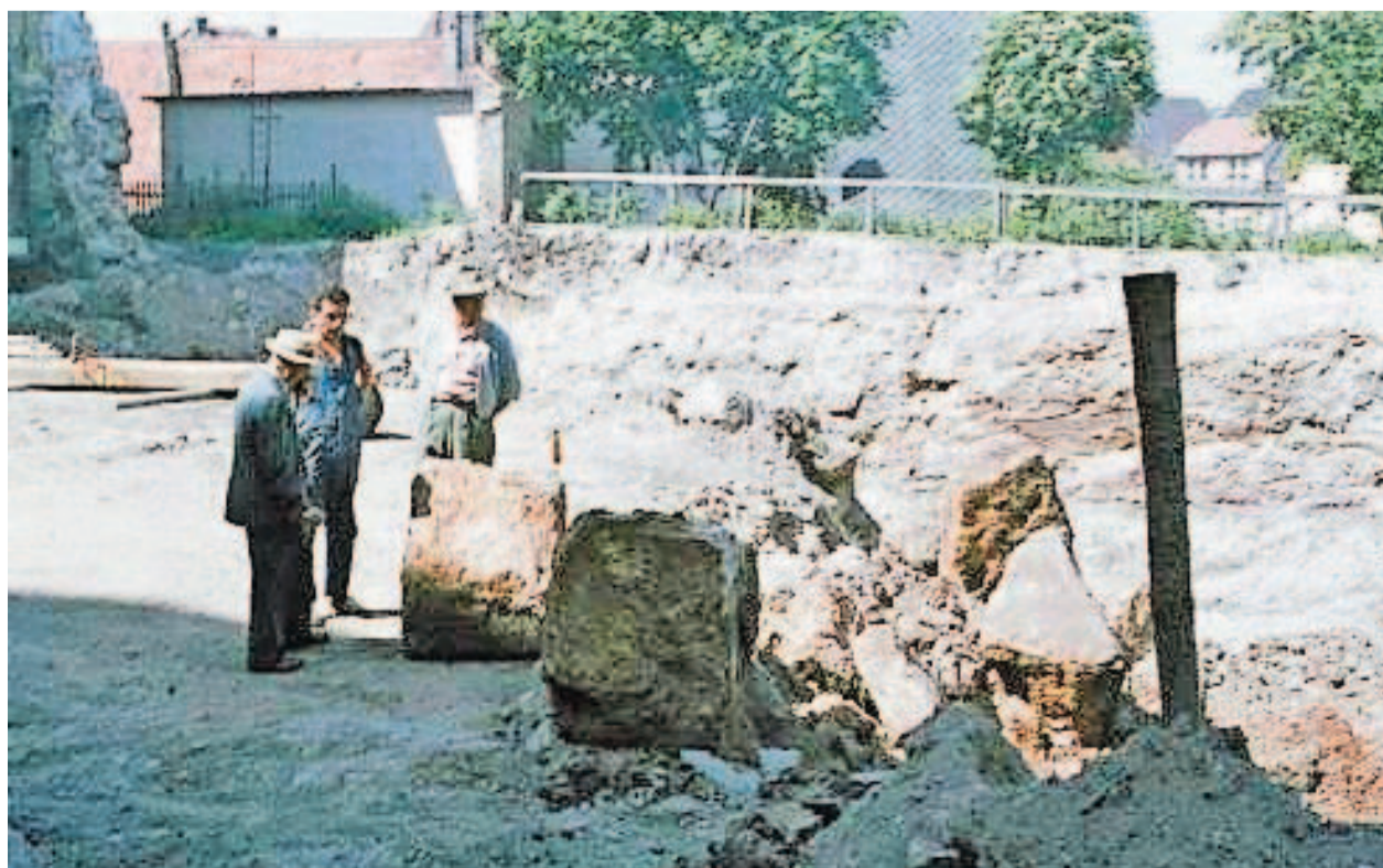
Herzogenaauracher Bauarbeiten 1964: Schon seinerzeit wurde deutlich, auf welchem massiven Untergrund der Rathausbau errichtet wurde.
