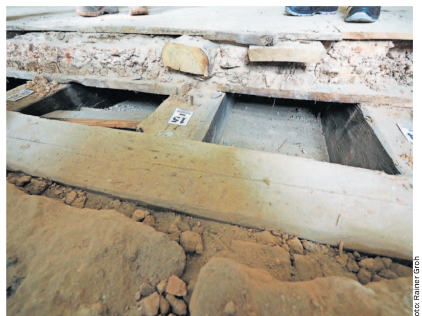
Im ältesten Trakt, dem Südflügel, fand sich auf den Tragebalken ein Sichtestrich, der wohl aus dem Mittelalter stammt, später mit Holzdielen überbaut wurde.
