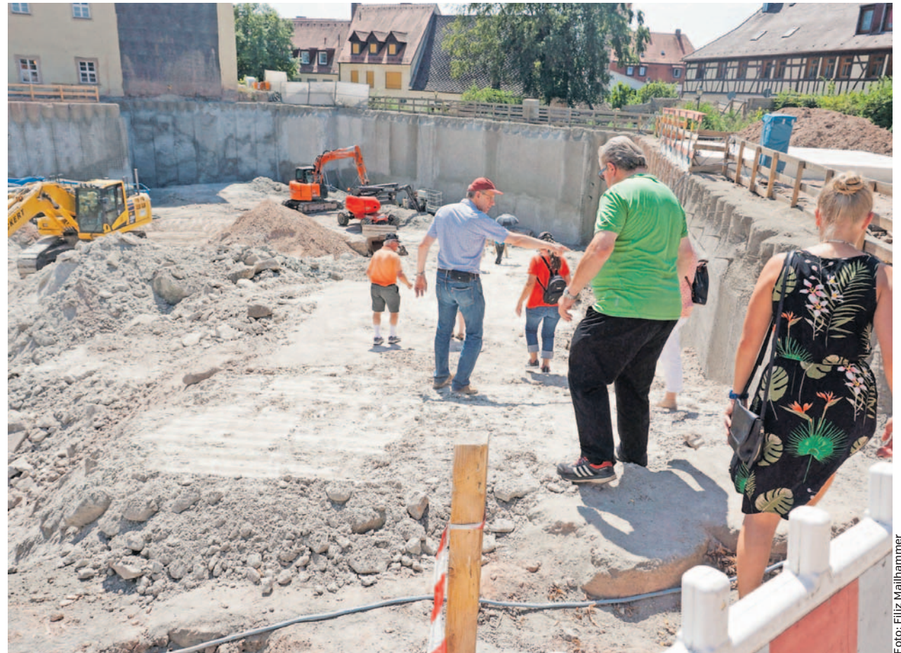
Hinab in die Tiefe: Bei einem Baustellenrundgang konnten sich Bürger einen Eindruck vom Fortgang der Arbeiten verschaffen.
