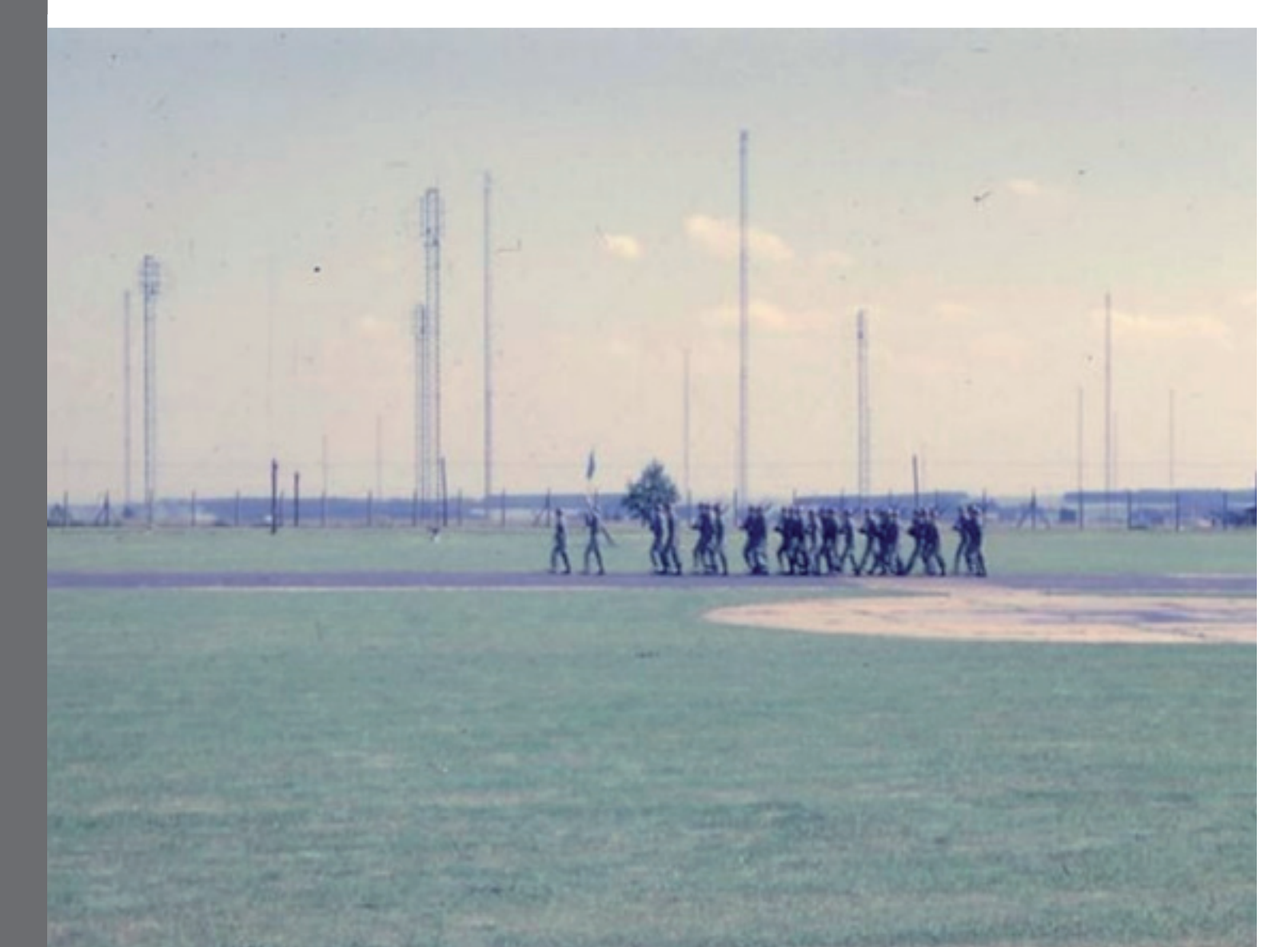
Antennen und Gittermasten auf dem ehemaligen Rollfeld, Aufnahme nicht datiert
