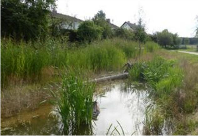
Durch die Abflachung der Uferböschungen konnte der Retentionsraum in der Bachaue deutlich vergrößert werden. Die unbefestigten Ufer lassen zukünftig die Eigendynamik des Gewässers wieder zu.
